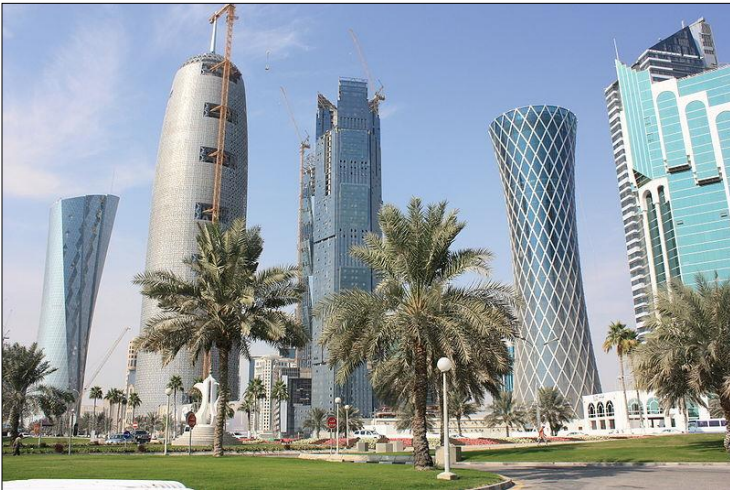
Výškové budovy v Dauhá
